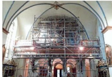
Die Orgelempore wird nicht mehr lange eingerüstet sein. In einigen Monaten wird die Orgel feierlich wieder eingeweiht.
